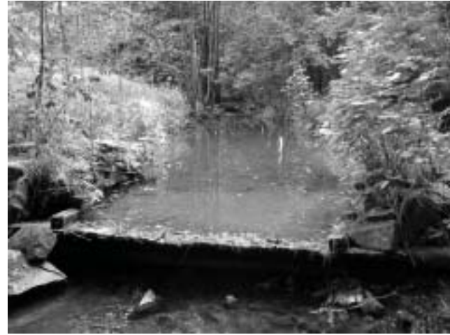
Erhaltene hölzerne Sohlschanzenkonstruktion an der Langenau.
