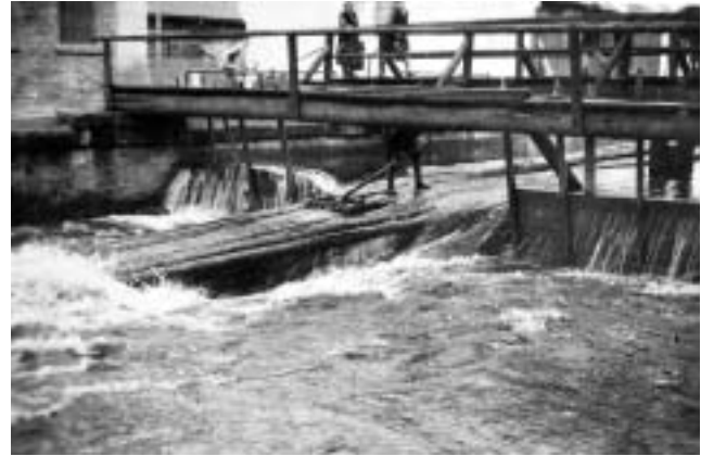
Auf diesem Foto einer Floßdurchfahrt durch das Herrenwehr in Kronach ist deutlich das System der Wehröffnung zu erkennen. Die Wehrleisten wurden kurz vor der Floßdurchfahrt herausgenommen und auf dem Wehrsteg abgelegt.
