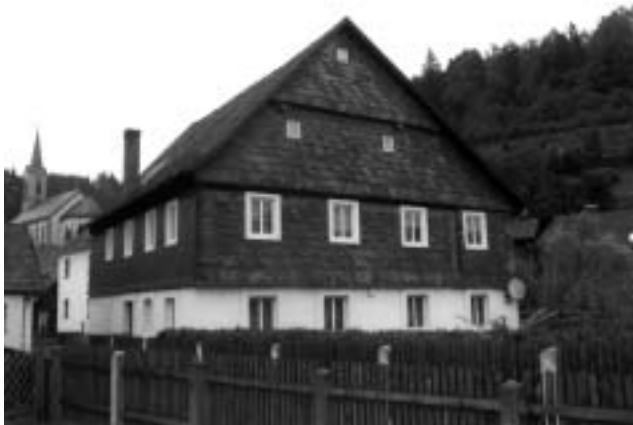
Mühlgraben 17 in Wallenfels – ein Floßherrenhaus des 18. Jahrhunderts.
