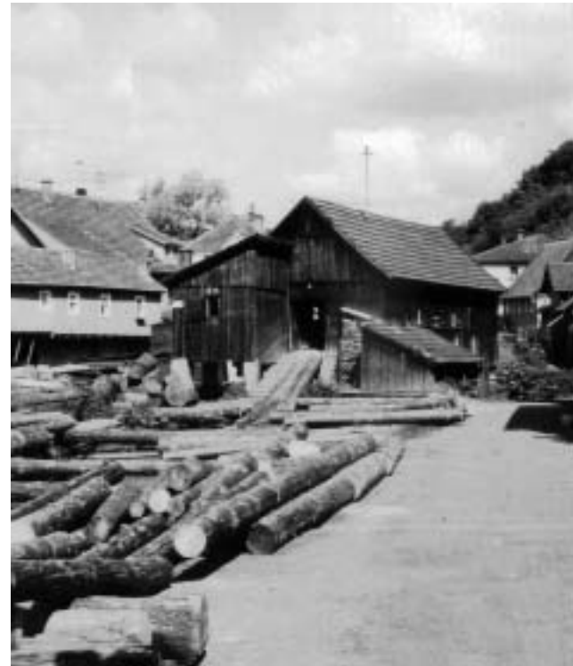
Blöcher auf dem Lagerplatz vor der Bergschneidmühle in Wallenfels. Ein Bloch wird gerade über die Rampe aus dem Bach in die Mühle gezogen.
