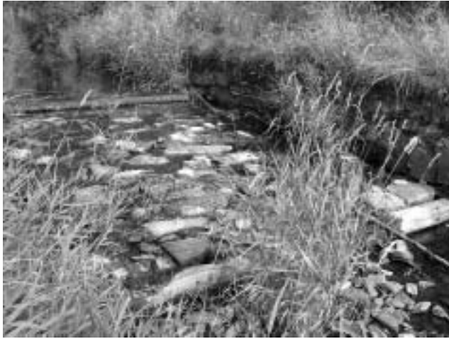
An der Mündung der Langenau ist ihr Gefälle durch einen Sohlabsturz aus Holz und Stein abgemildert.
