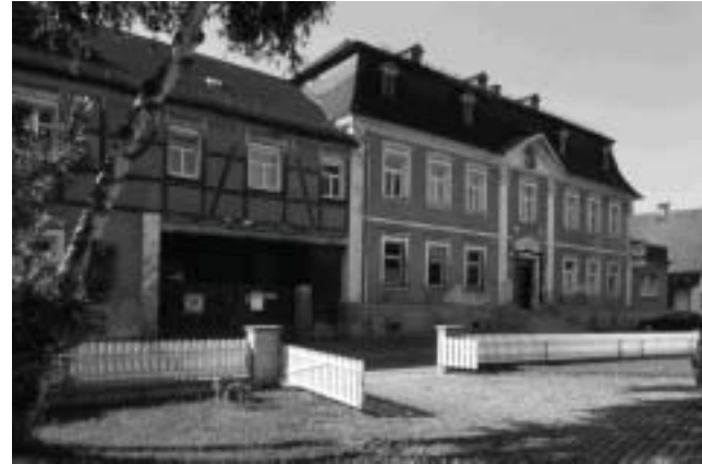
Steinwiesen, Ankergrasse 9. Der fast schlossartige Bau des Floßherrenhauses wird durch die direkt angebauten Wirtschaftsgebäude wieder in den dörflichen Zusammenhang gerückt.
