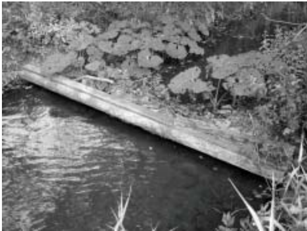
Ein vollständig erhaltener hölzerner Sohlabsturz an der Langenau mit seitlichen Aufschieblingen.
