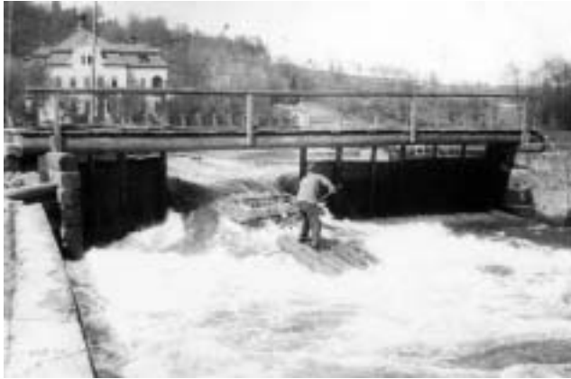
Das Wasenwehr in Kronach als traditionelles Nadelwehr in Holzbauweise bei einer Floßdurchfahrt in den 1920er Jahren. Lediglich die Widerlager sind in Steinbauweise errichtet.
