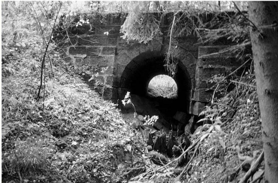
Einbogiger Wasserdurchlass aus Sandstein am Chausseedamm der „Alten Coburger Strasse“. Foto: Thomas Gunzelmann
