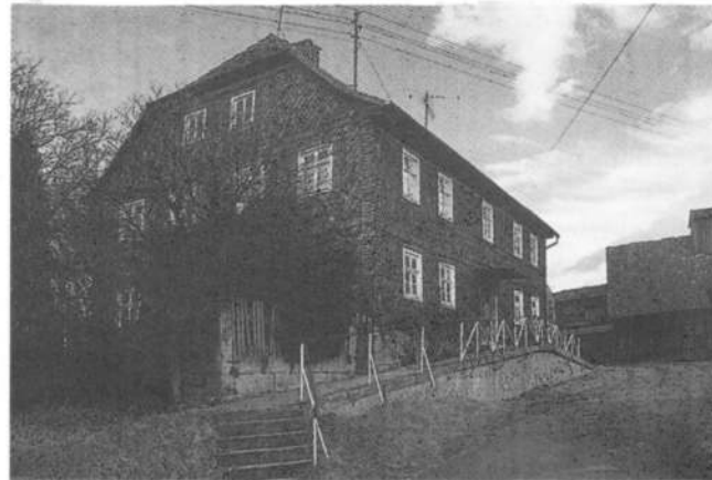
7. Tiefenroth – Birkacher Str. 10; zweigeschossiges Wohnhaus mit Halbwalmdach, Fachwerk, schieferverkleidet; Anfang 19. Jahrhundert (Denkmal)
