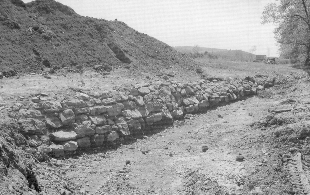
Oben: Im Zuge der Renaturierungsmaßnahmen zur Landesgartenschau freigelegte Ufersicherung an einem historischen Rodachlauf dicht südlich der Haßlachmündung, mindestens aus dem 18. Jahrhundert.
