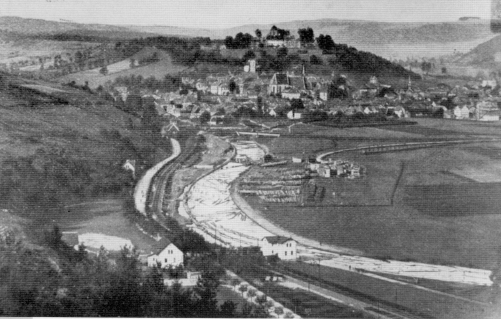
Oben: Kronach vom Haßbacher Berg aus dem Jahr 1902. Die Eisenbahnlinie nach Probstzella ist im Bereich Kronach noch eingleisig, die Lokalbahn nach Nordhalben und der Holzladeplatz am Kleienwog existieren schon. Die Haßlach wird gerade korrigiert und mit Uferschutzbauten versehen, um Platz für den zweigleisigen Ausbau der Bahnlinie zu schaffen.
