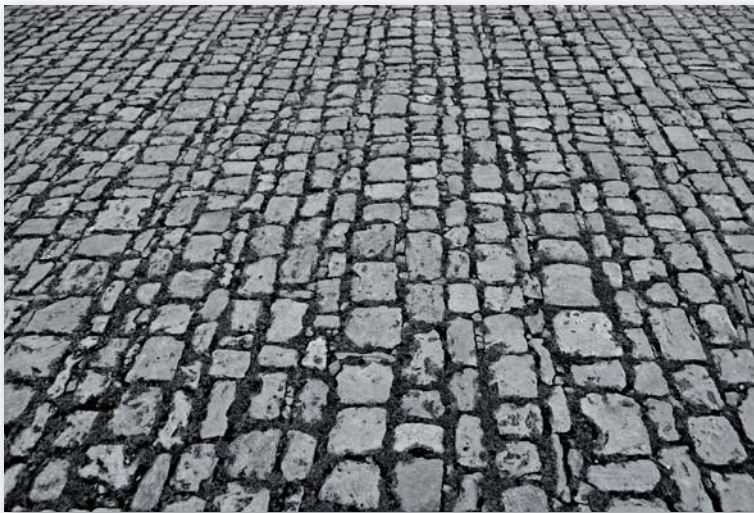
Abb. 3: 30 „Tütschengereuther Pflaster“ aus der „Dolomitischen Arkose“ des Mittleren Burgsandsteins in der typischen Reihenverlegung. Vom Spätmittelalter bis zur Mitte des 19. Jahrhunderts in Bamberg als Standardpflaster für Straßen, Plätze und Höfe eingesetzt, hier im Hof von Brückenstraße 1. Foto: T. Gunzelmann, 2011
